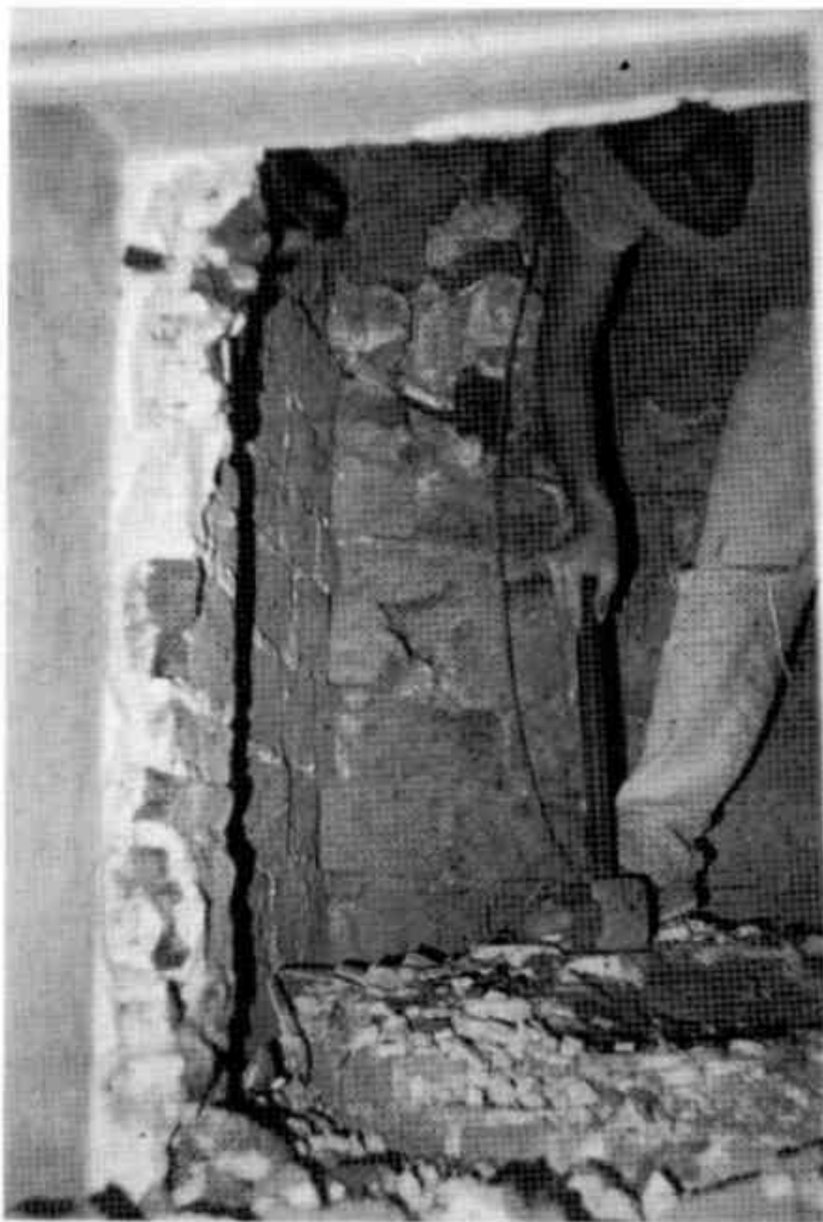
Foto 3: Nestor Rosso, durante la demolición de la columna del Gautier.
